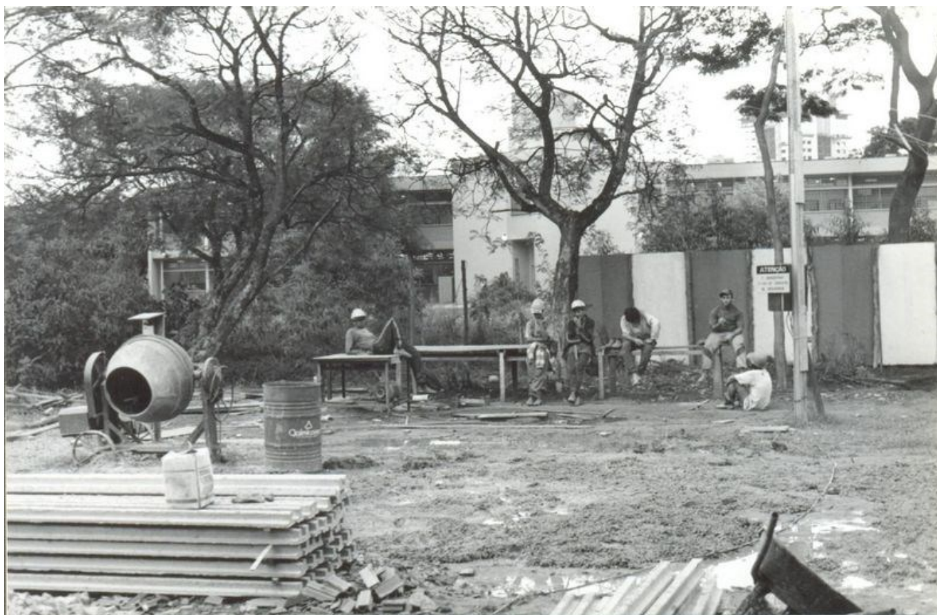
Obras do prédio da Biblioteca Dante Moreira Leite do Instituto de Psicologia da USP. Imagem digitalizada a partir do original disponibilizado pelo Centro Acadêmico "Iara Iavelberg" do Instituto de Psicologia da USP.
